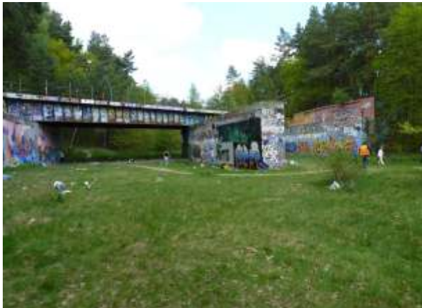
Bild 10 – Brücke der Stammbahn über die ehemalige Autobahntrasse
