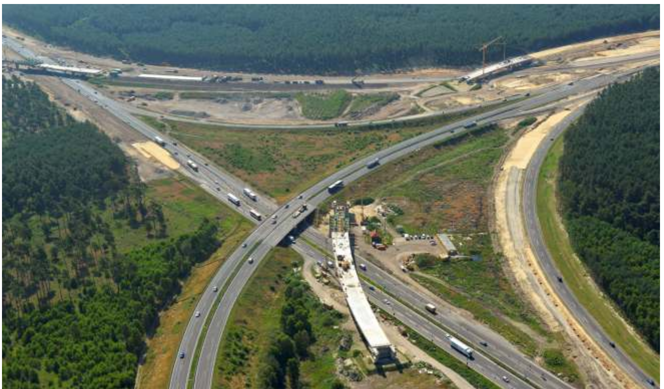
Bild 17 – Luftaufnahme AD Havelland während des Baus
