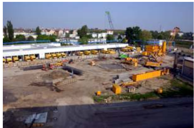
Bild 3 – Blick aus dem Fenster des Baubüros auf das Baufeld von Los 1
