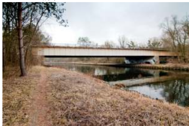
Bild 8 – Brücke über den Teltowkanal der ursprünglichen Autobahntrasse
