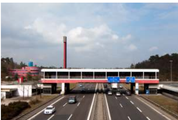
Bild 7 – Brückenhaus der früheren Grenzübergangsstelle Dreilinden (Checkpoint Bravo)
