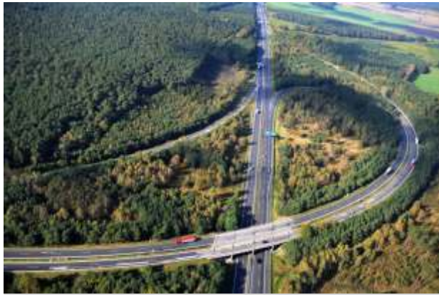
Bild 12 – AD Havelland vor dem Umbau 2011
