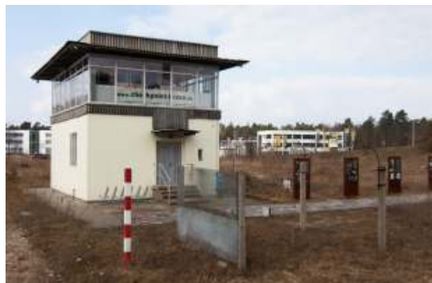
Bild 9 – Grenzturm der ehemaligen Grenzübergangsstelle Drewitz
